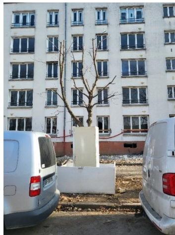
Figure 2 : Type de protection mise en place sur les arbres existants
