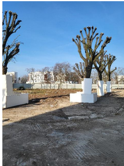
Figure 4 : Arbres qui seront au milieu des travaux de désimperméabilisation
